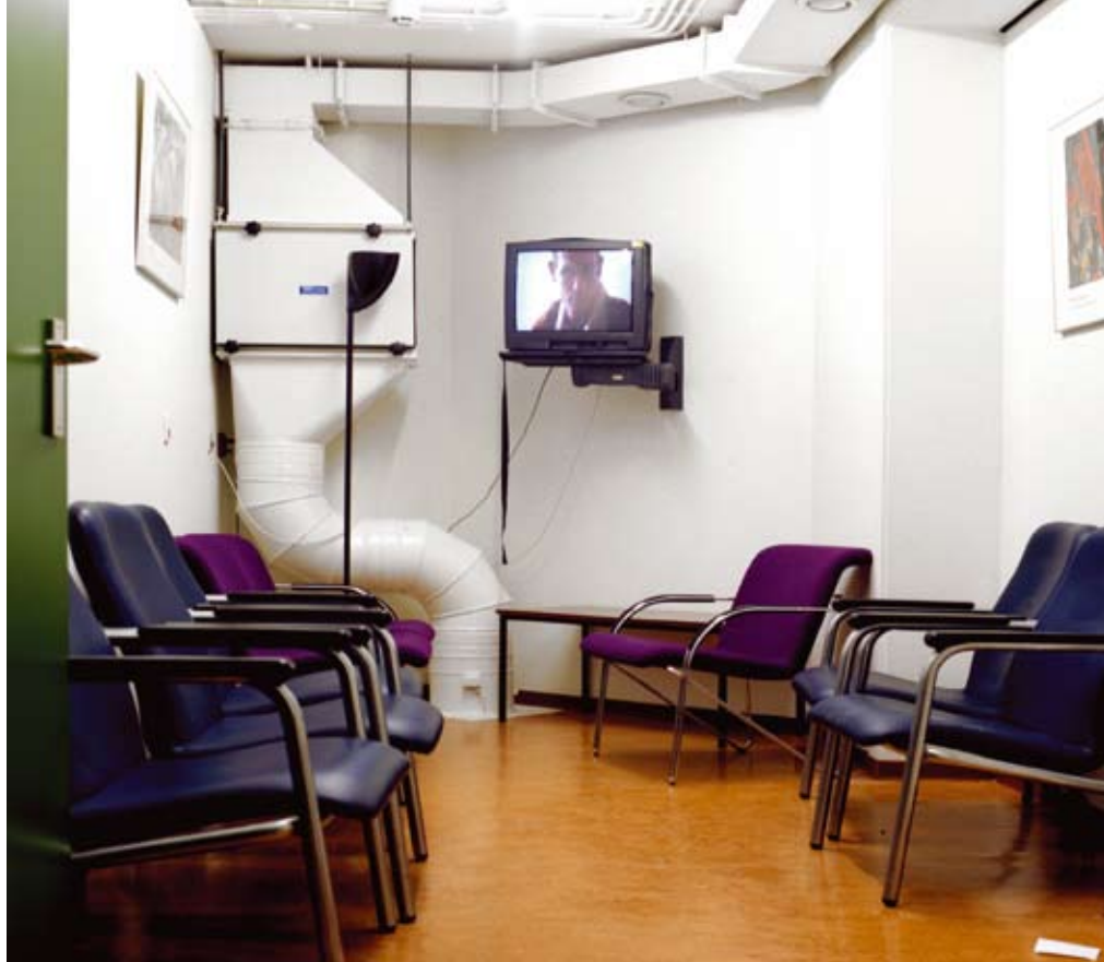
Patiënten die mogelijk zijn besmet, mogen de afdeling niet af. Televisiekijken mogen ze natuurlijk wel. De recreatiezaal en de ruimten daarnaast hebben een eigen luchtcirculatiesysteem met onderdruk.
